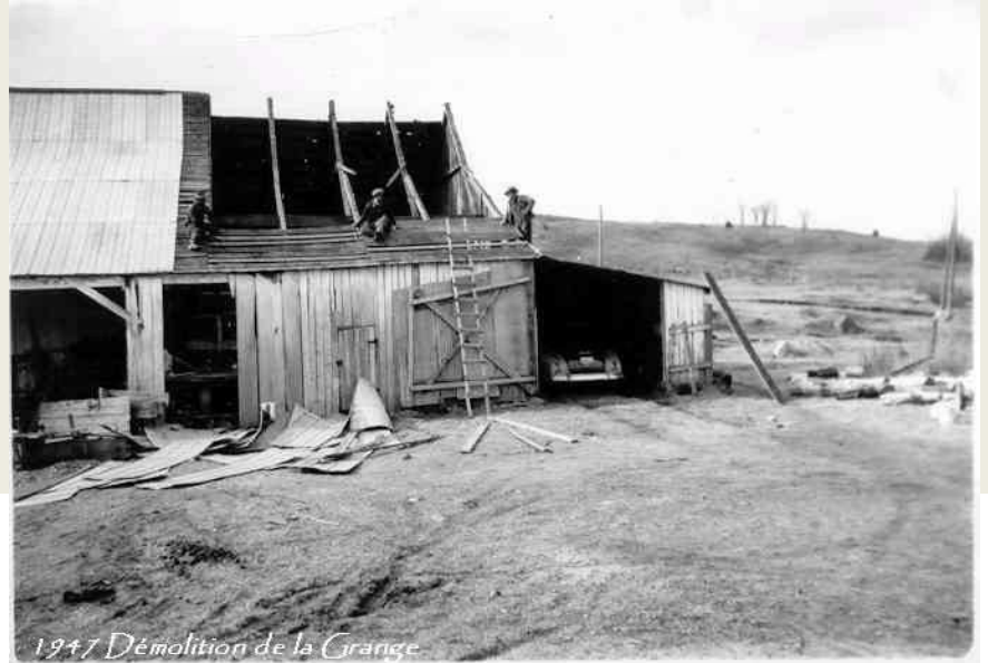
1947 : Démolition de la grange, Jocelyne Pion archives.
